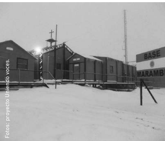
Imagen 13. Ingreso principal al alojamiento de Base Marambio.
