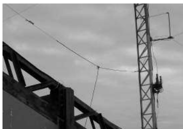
Una de las antenas instaladas por UV.
