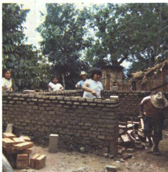
El trabajo en la comunidad. Construcción de viviendas.
