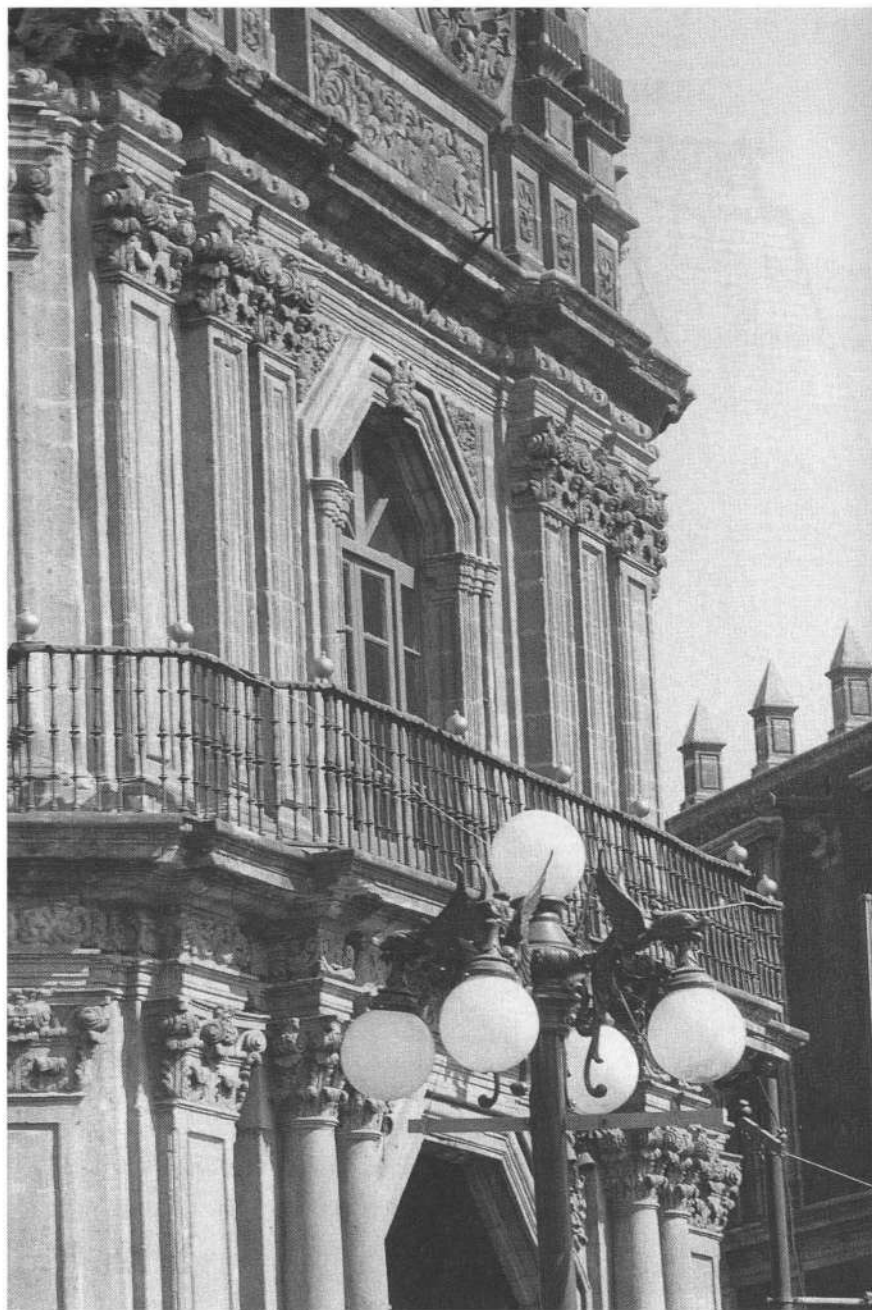
4. Segundo cuerpo de la fachada
