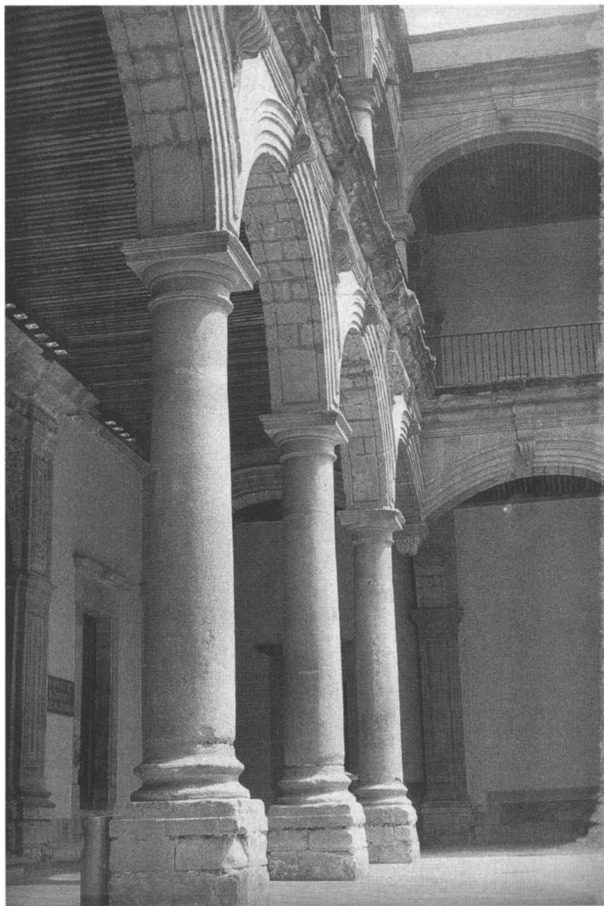
11. Corredor oriente del patio principal
