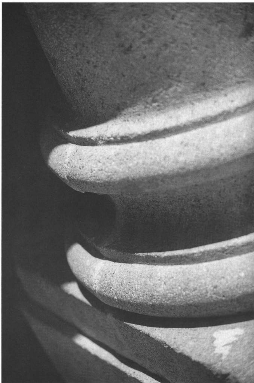
12. Detalle del basamento de una de las columnas del patio principal
