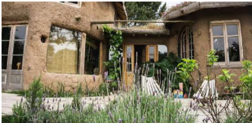
Figura 3. Bioconstrucción en barro
