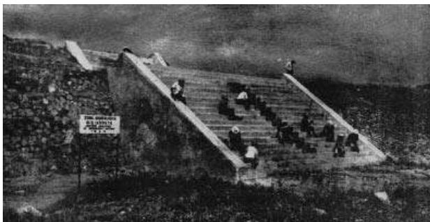
Fig. 4. Trabajos llevados a cabo en la escalera de la fachada principal de la pirámide, a fin de enmendar algo lo hecho anteriormente.
