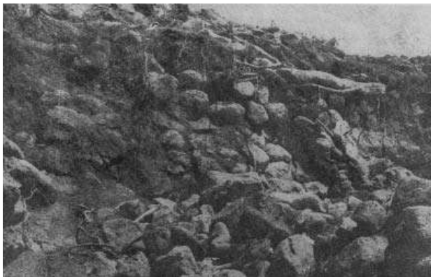
Fig. 3. Nótese en esta fotografía, la ausencia absoluta de argamasa que une las piezas pétreas de la construcción.
