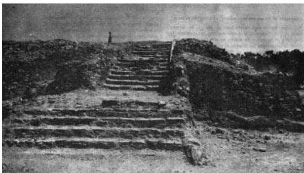
Fig. 6. Vista de la escalera sobrepuesta de la pirámide, antes de emprender los trabajos de consolidación y reconstrucción de la misma.
