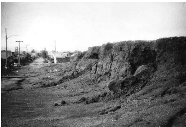
Fig. 3. Daños causados en el montículo central por la apertura de una calle.
