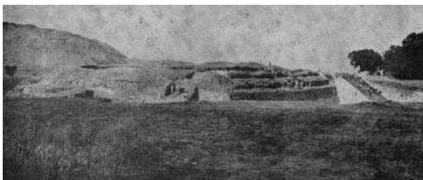
Fig. 2. Vista general de la pirámide, abarcando sus lados Oriente y Sureste, durante los trabajos llevados a cabo en la escalera y en los cuerpos de su fachada principal.
