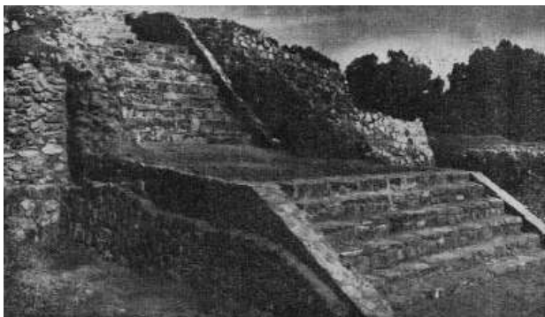
Fig. 3 La misma escalera sobrepuesta del lado Sureste de la pirámide, una vez terminados los trabajos de exploración, consolidación y restauración.
