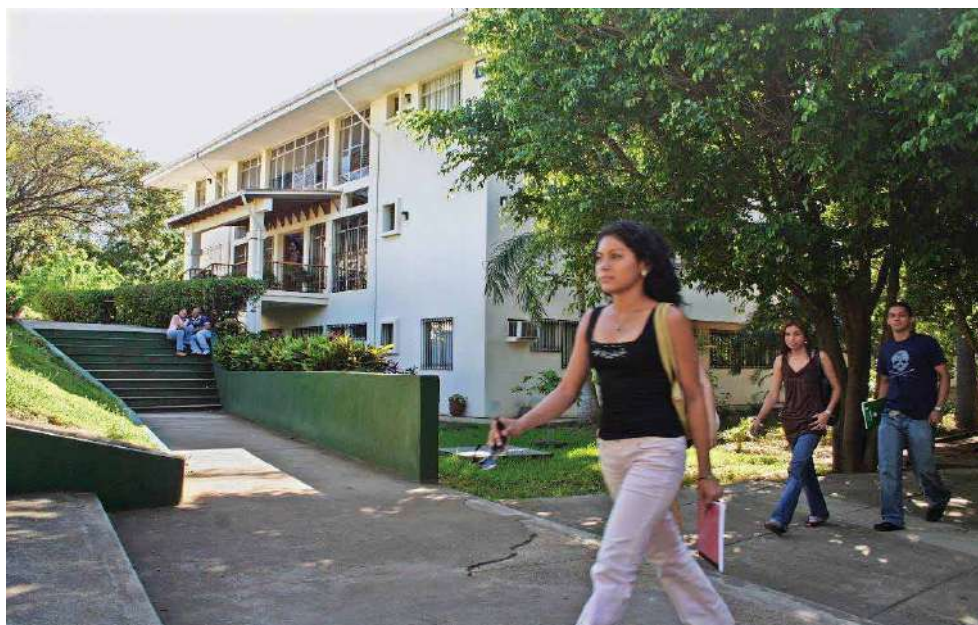
Imagen 1. El nuevo edificio del IHNCA en el campus de la Universidad Centroamericana (UCA) en Managua.
